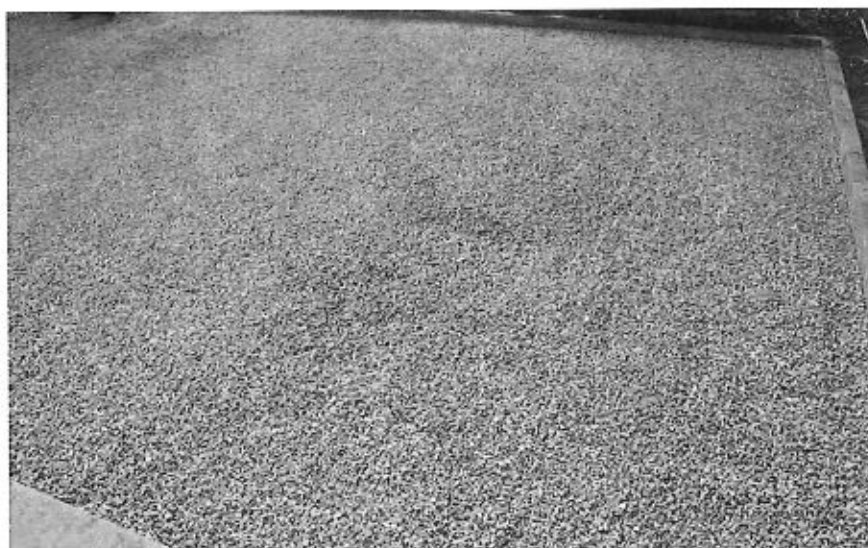
Immagine fotografica rappresentativa, inghiaioamento tramite celle contenitive
